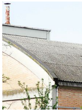
Alle spalle, tetto in cemento amianto
